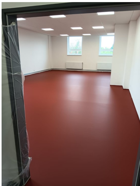
vnitřní úpravy multifunkčního centra
