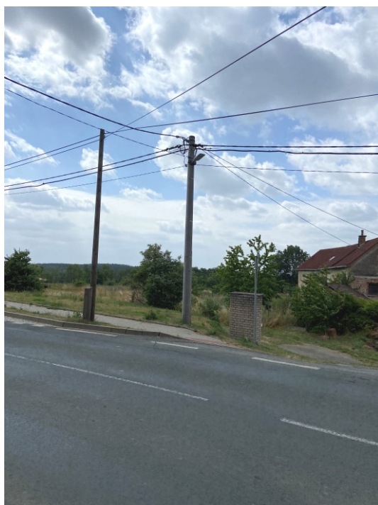
výměna veřejného osvětlení - Víchov
